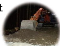
軟弱地盤に対応するための土木シートを用いた路網開設の様子
